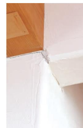
壁と天井の境目の漆喰が数センチだけ剥がれ落ちている。「被害がこれだけで済んだのが幸い」とK様
